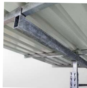
Střešní trámy mají držáky ve tvaru U k upevnění držáků plechu
