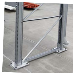
Sloupy regálu se svodem dešťové vody
