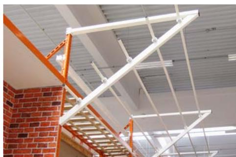
Vorbau-Elemente, z.B. für Flaschenzüge (rechts oben) oder Ventilatoren (rechts, mit beweglichen Haltern)
