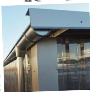
links: Blick auf das Trapezblechdach, den Lichtstreifen und die Blechkanten, die vorne und hinten für einen sauberen Abschluss des Dachs sorgen
