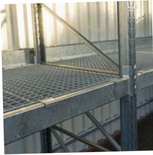
Im ersten Feld befinden sich Kreuzverbände zur Stabilisierung der Regalkonstruktion (bei längeren Hallen: in jedem dritten Feld)
